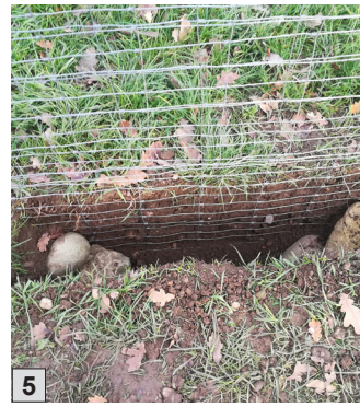
5 Nachrüstung Gehegewildzaun durch vertikale Zaunverlängerung aus verzinktem Knotengeflecht
