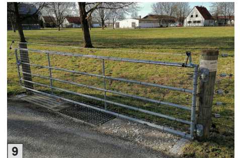
9 Untergrabschutz am Tor durch befestigten Untergrund (Betonspaltelement, Gummimatte, Mineralgemisch, Pflaster, Teer) und maximal 10 cm Bodenabstand
