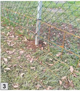
3 Nachrüstung Außenzaun Photovoltaik-anlage mit Zaunschürze aus Baustahlmatte mit Maschenweite 19 x 19 cm
