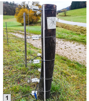
1 Festzaun mit 5 Stahldrähten (Abstand 20/40/60/90/120), Keramik-Isolatoren, Eckpfosten aus Akazienholz mit Warnschild
